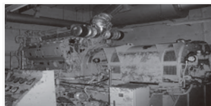
非常用発電設備の被災状況
