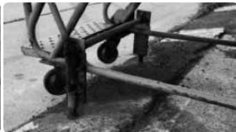
〈29番スポットアスファルト隆起〉
