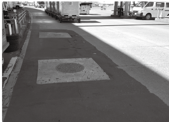
〈車両通行帯の段差〉
