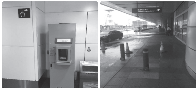
〈国際線ターミナルに設置されている給湯器〉 〈第2ターミナルの雨漏り〉
