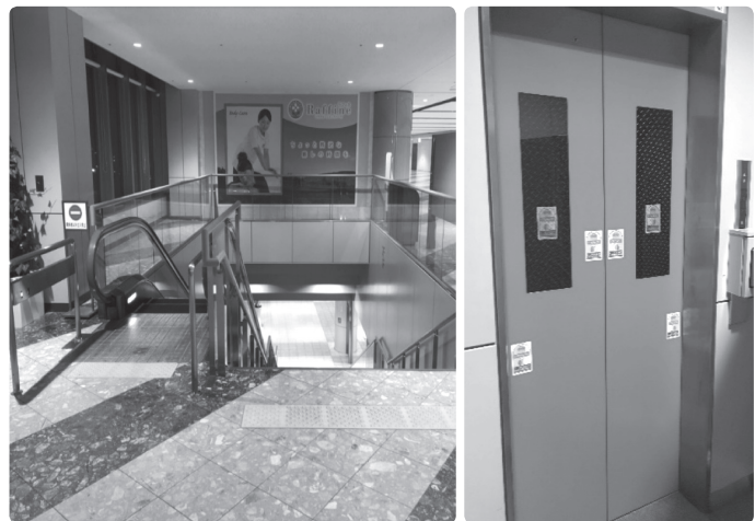
〈片側のみのエスカレーター〉 〈従業員不在時使用できないエレベーター〉
