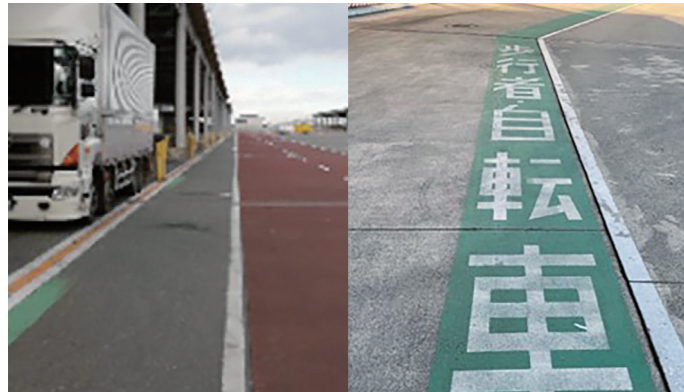
▲歩行者動線がわかりにくい ▲他エリアの塗装
