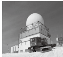
航空路監視レーダー (航空路の航空機の監視)
