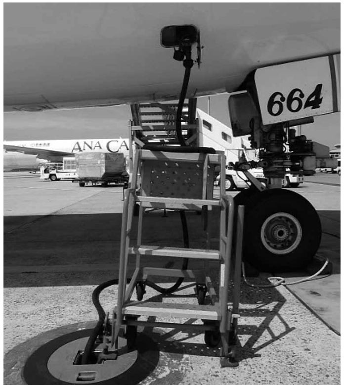
マンホール隆起のため、作業用脚立が水平に立てられない。
