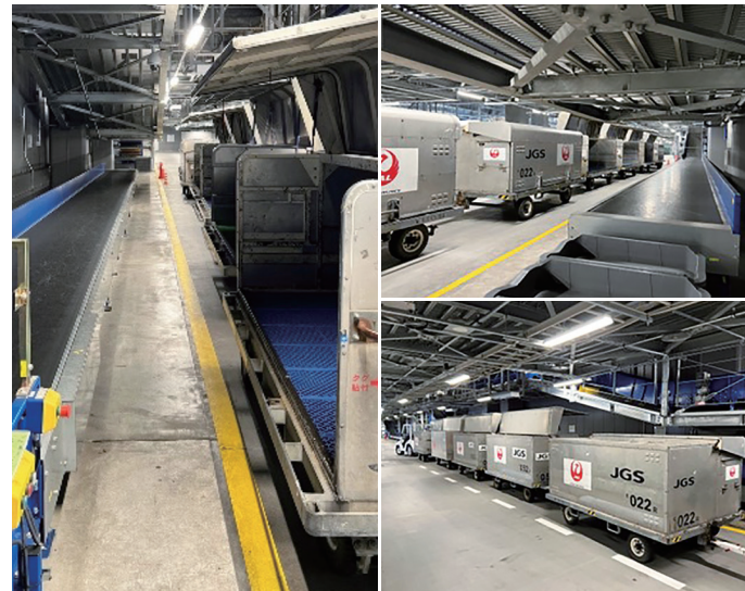
▲Cベルトにて6台連結搬入時、4台までしか開閉することができない。
