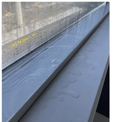
▲エアライン棟結露による水たまり
