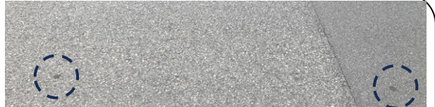
路面に約1m間隔で設置された磁気マーカー
